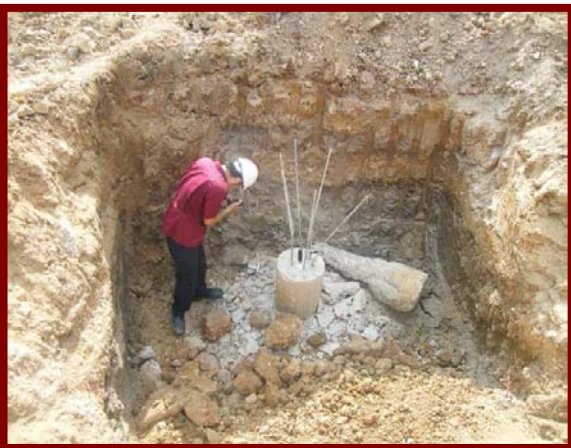
การทดสอบเสาเข็ม
