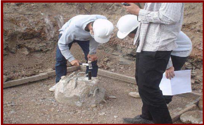
การทดสอบเสาเข็ม
