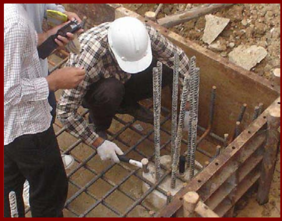
การทดสอบเสาเข็ม
