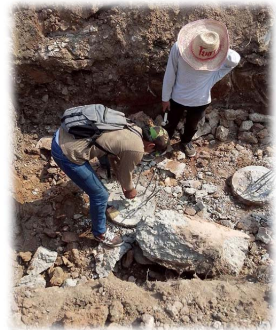
การตรวจสอบความสมบูรณ์ของเสาเข็ม
