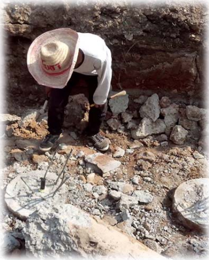
การตรวจสอบความแข็งของเสาเข็ม
