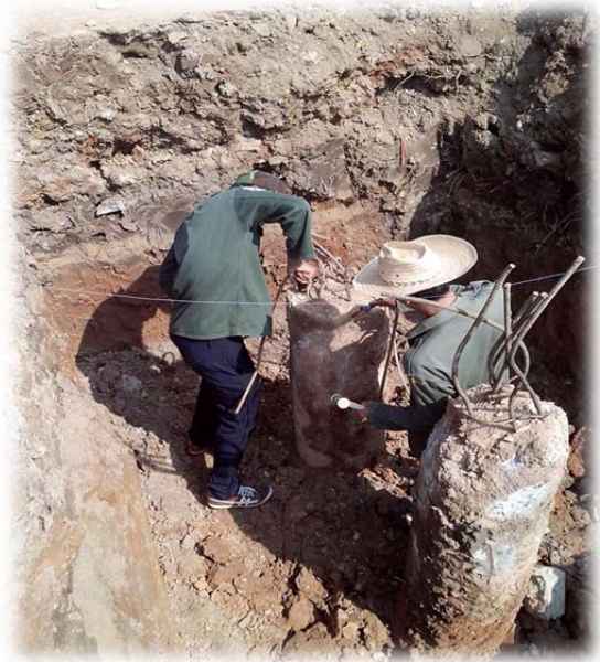
การติดตั้งชุดทดสอบความสมบูรณ์ของเสาเข็ม
