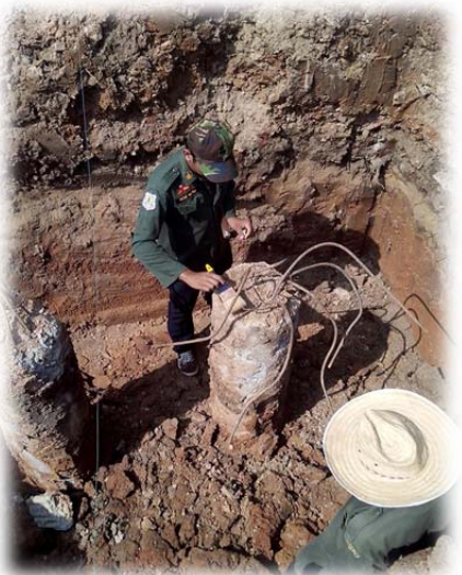
การวัดขนาดเสาเข็ม
